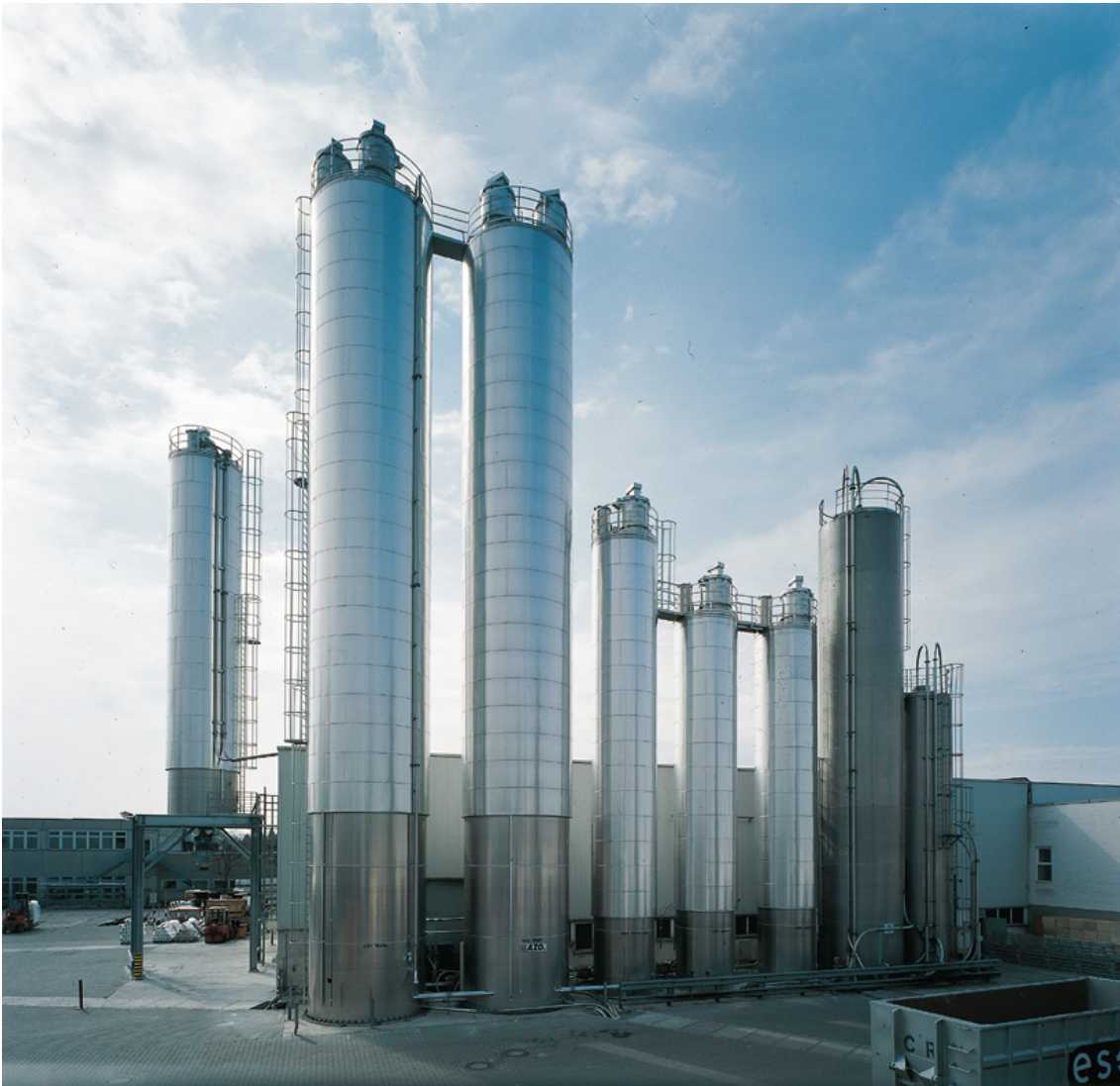
Bild 1: Siloanlage mit Außensilos (AZO GmbH & Co. KG)
