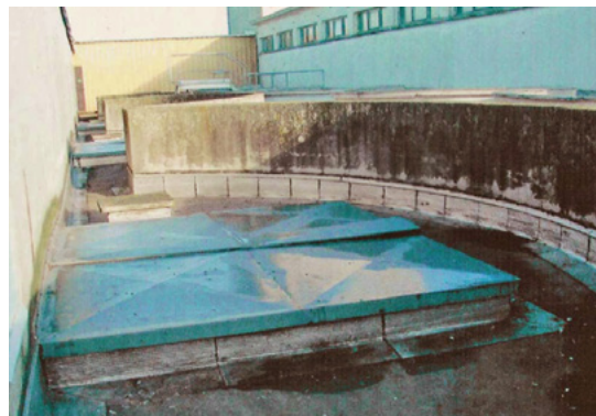
Bild 36: Silogebäude aus Stahlbeton ohne Aspiration, Explosionsdruckentlastung in den Außenbereich des Silogebäudes geführt
