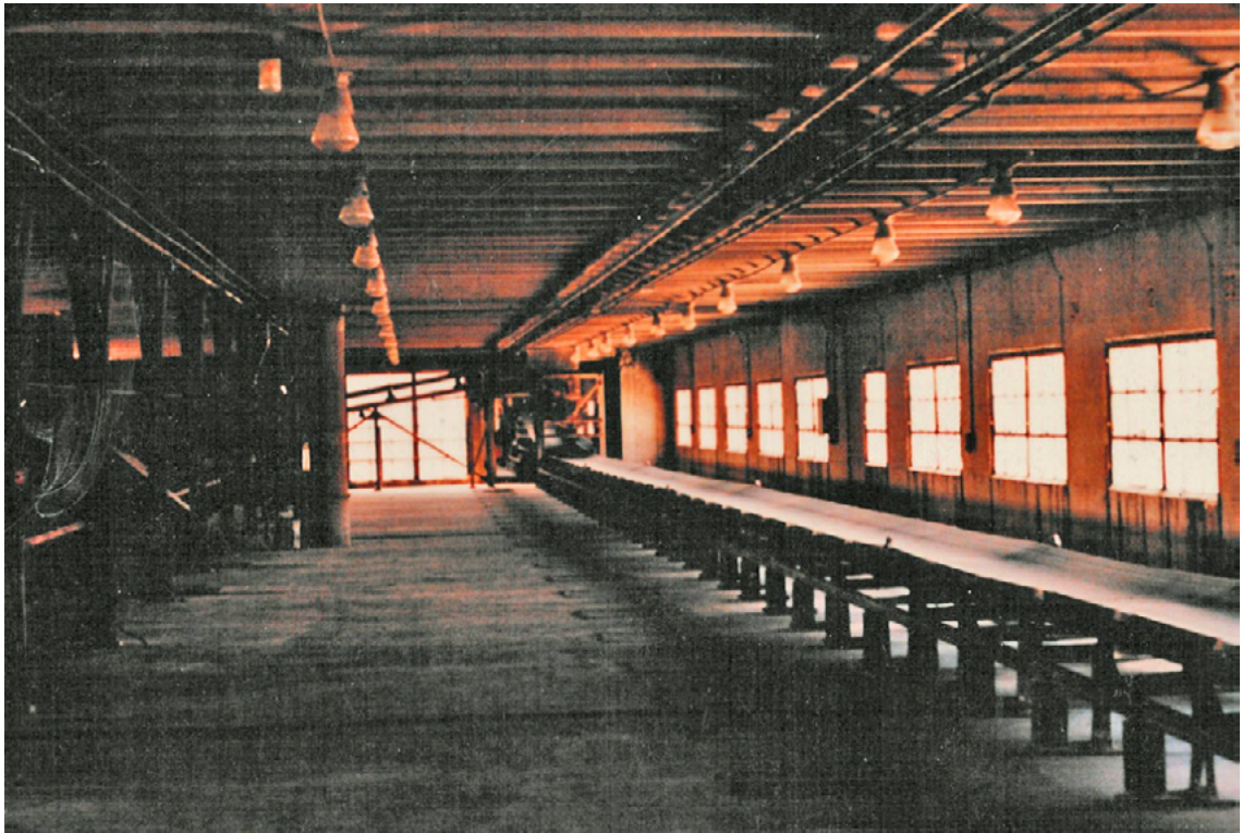
Bild 40: Siloboden mit Förderband und splitterfreien Fensterelementen als Druckentlastung
