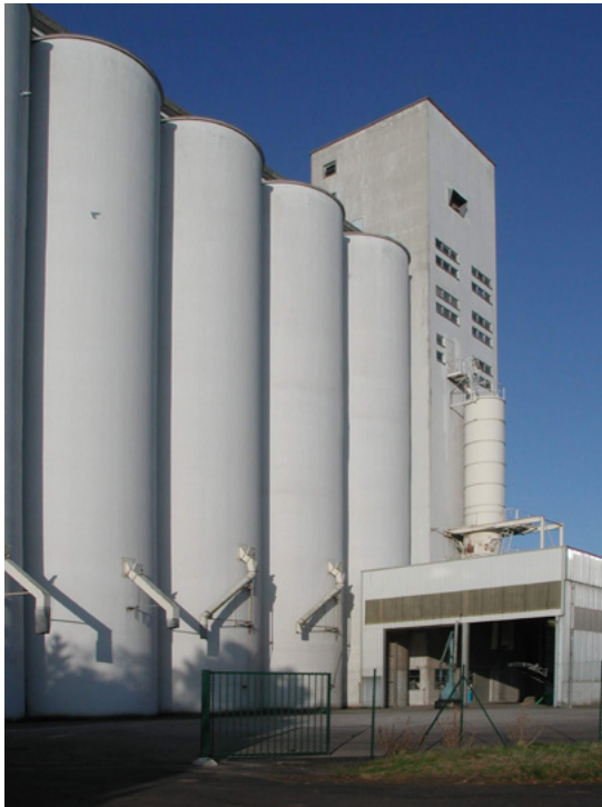
Bild 37: Silos mit Maschinengebäude und Druckentlastungsflächen
