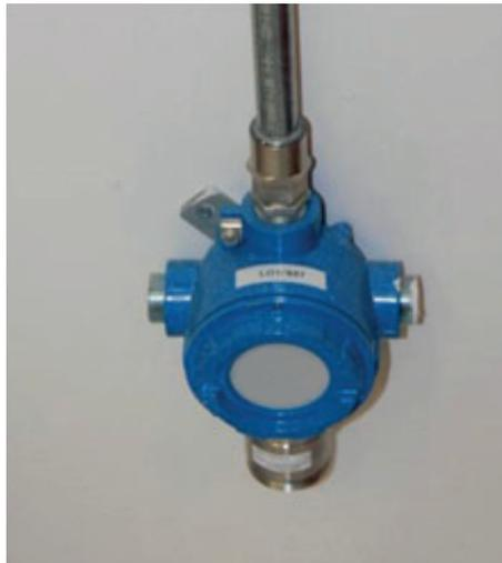
**Figura 20:** Sensore di livello ossigeno per ambienti dove si usano gas inerti
