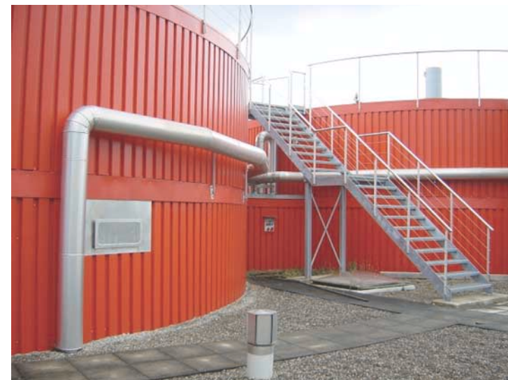
Bild 16: Zwei Faultürme mit integrierten Gasometern 1)
