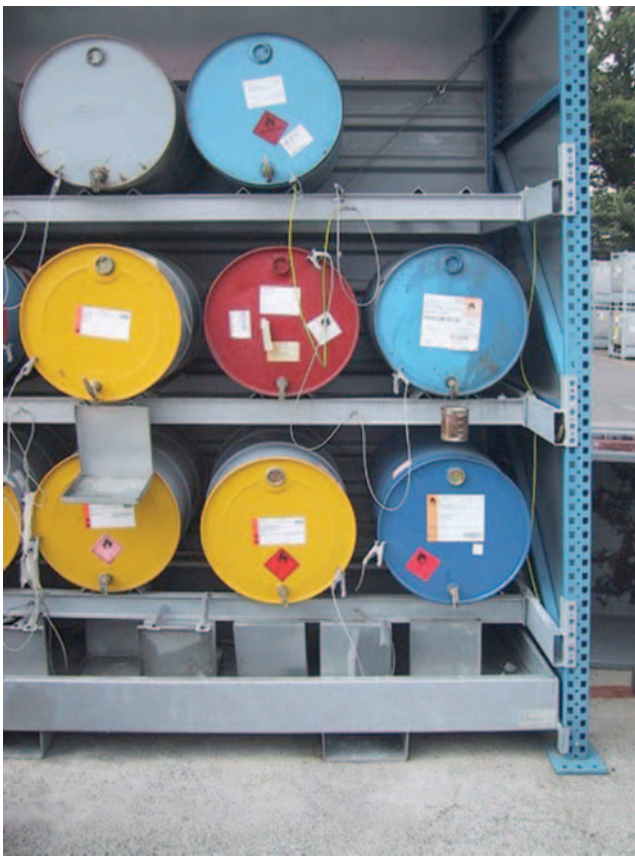
Bild 15: Lösemittelstation im Freien
