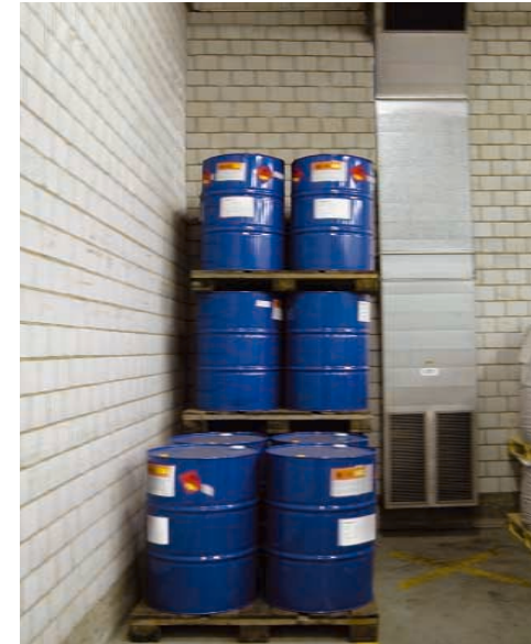
Bild 9: Lager für brennbare Flüssigkeiten mit einer technischen Lüftung
